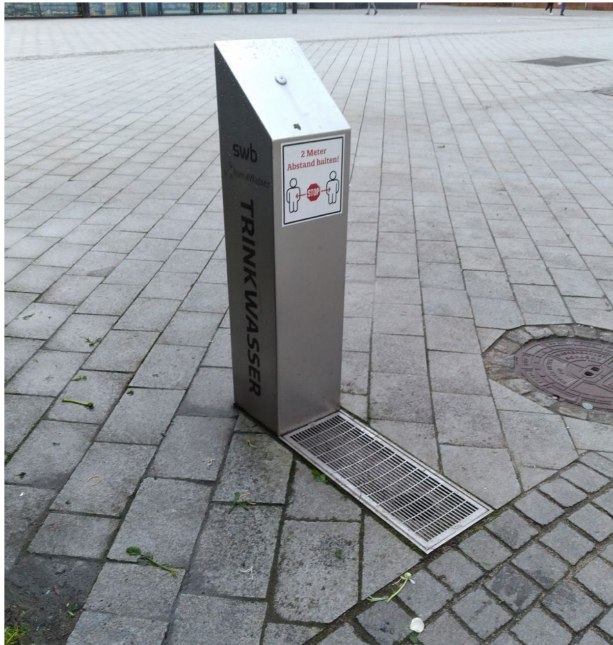
Abb. 21 Trinkwasserbrunnen auf dem Sedanplatz in Bremen-Nord
